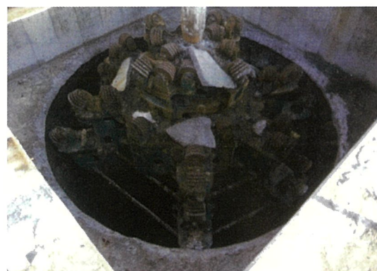
図 20 φ 6,000 ゲージ地上到達 完了
