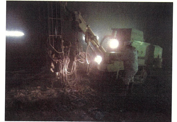
図 13 残壁部穿孔作業
