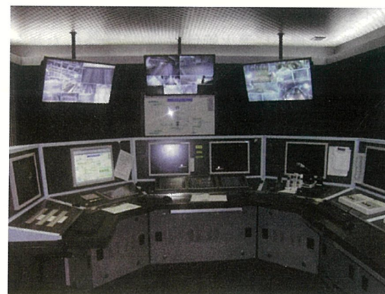
図 21 新中央制御室
